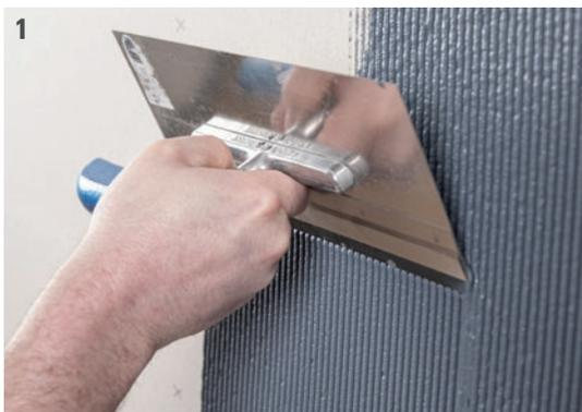
Magnetspachtel mit rostfreie Zahnkelle R2 auftragen und senkrecht durchzählen<sup>1</sup>. Zum Auftragen kann auch eine normale Stahlkelle genutzt werden, diese sollte aber auf jeden Fall rostfrei sein. An den Flächen, an denen sich das ALLFAtexx Spachtelvlies überlappt (Abstand ca. 1 m), den Magnetspachtel auch waagrecht durchzählen<sup>2</sup>.
