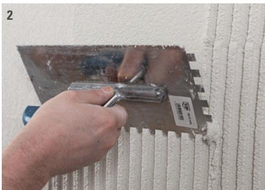
Stark überstehendes Material auf der durchgetrockneten Oberfläche mit einem Aufleger (Traufel) abstoßen<sup>5</sup>.
