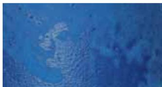
Dieser Beton zeigt nach Ausführung mit einer Standard-Fassadenbeschichtung deutliche Ausblühungen.
